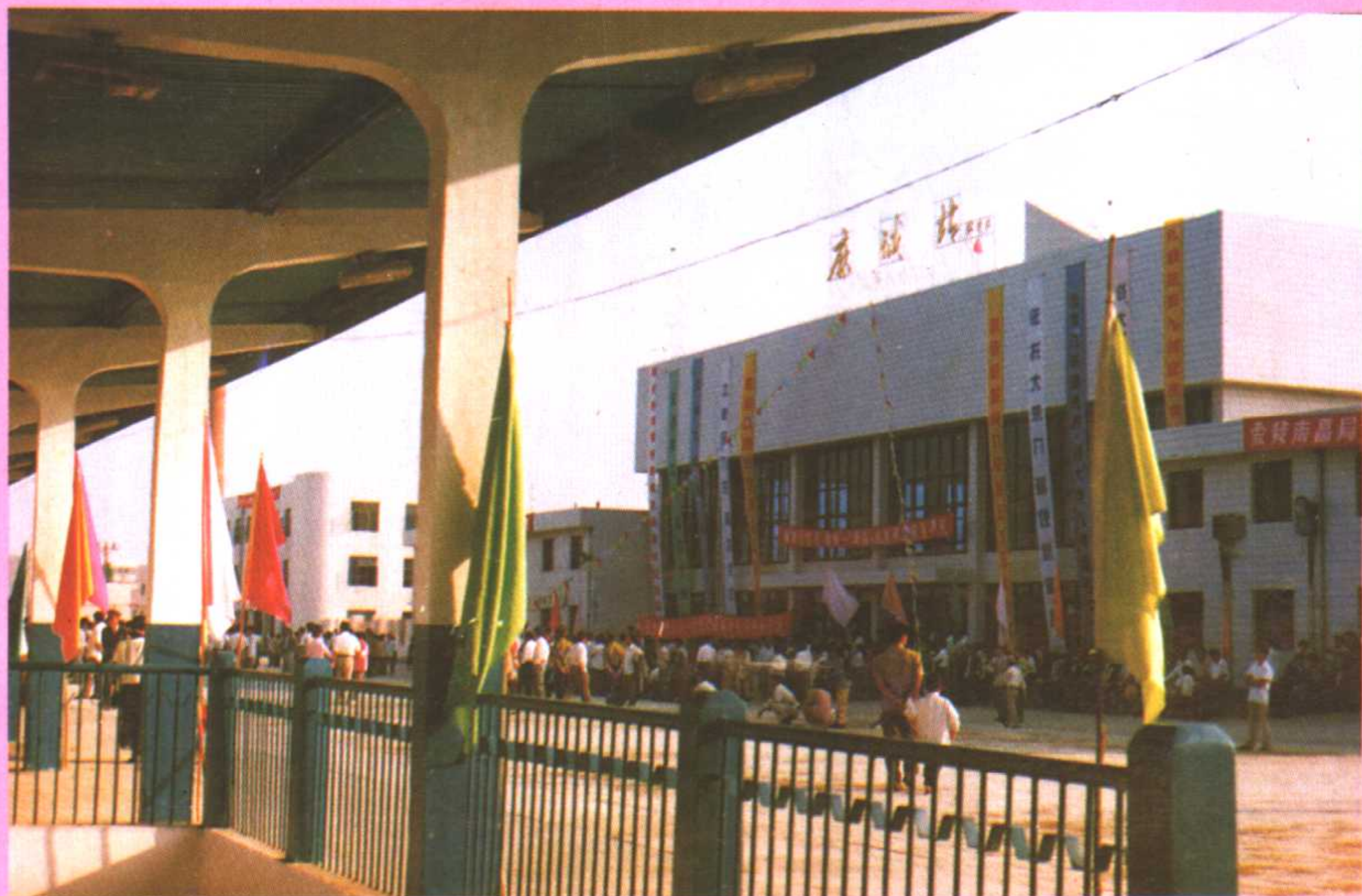
京九铁路麻城区段站
